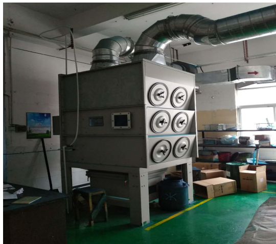
图 4.1.2-2 脉冲式滤筒除尘器
