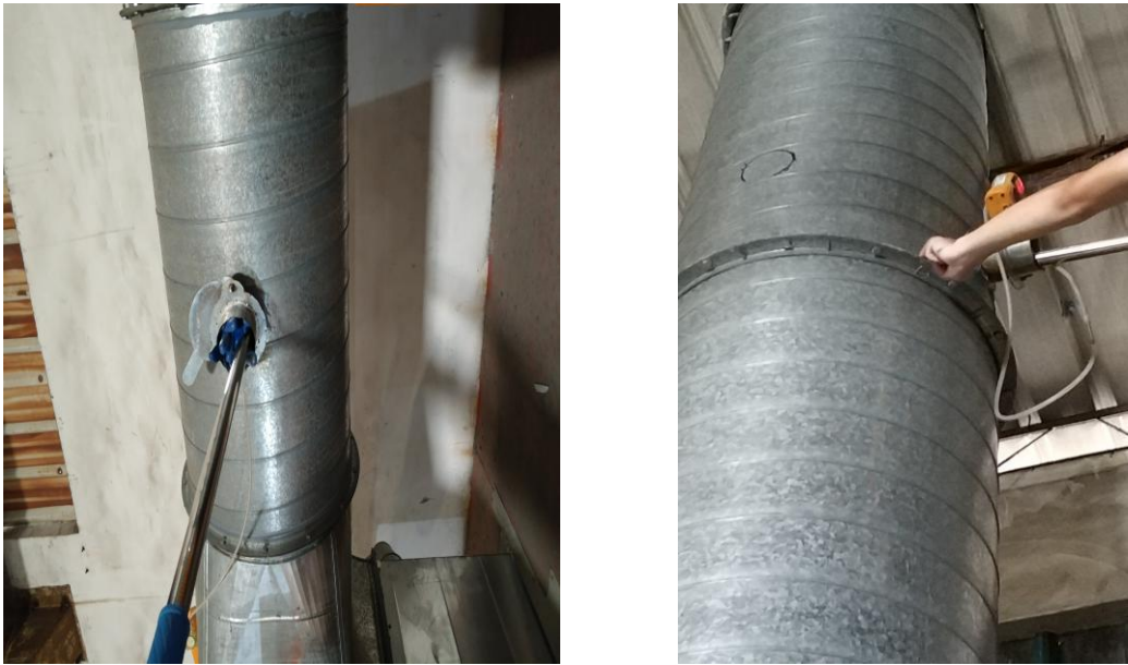
废气处理后监测口
