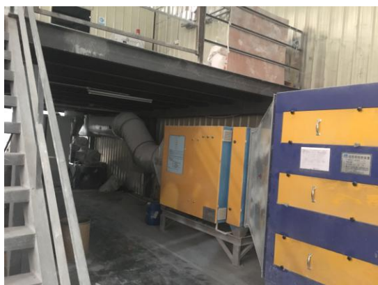
UV光解净化器+活性炭吸附装置
