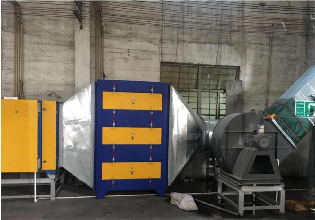
图 4.1.2-3 “干式过滤器+UV 光解+活性炭吸附”设备图
