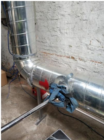
喷码、挤出废气处理前监测口
