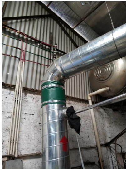
喷码、挤出废气处理后监测口
