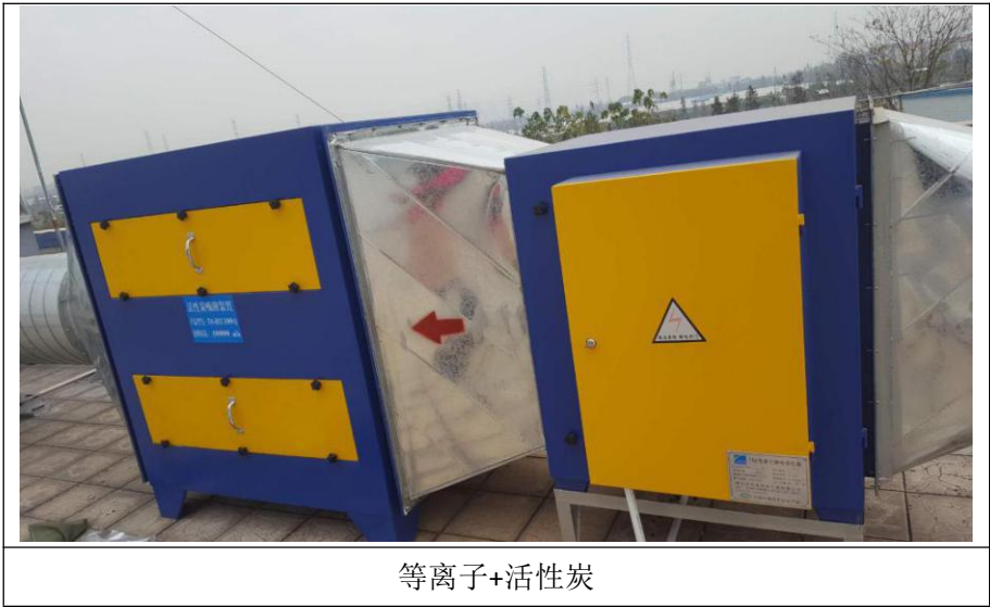
图 4.1.2-2 废气处理设施图
